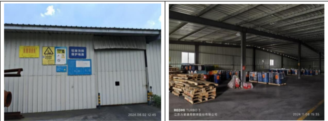
东厂区危废仓库设置情况
