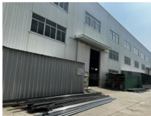
项目地北侧(江苏九鼎新材料股份有限公司板材车间)
