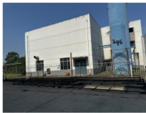
项目地西侧(江苏九鼎新材料有限公司辅助用房)
