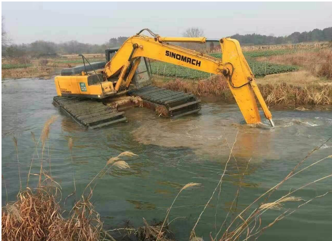
图 6.4.1 抓斗式挖泥船施工
