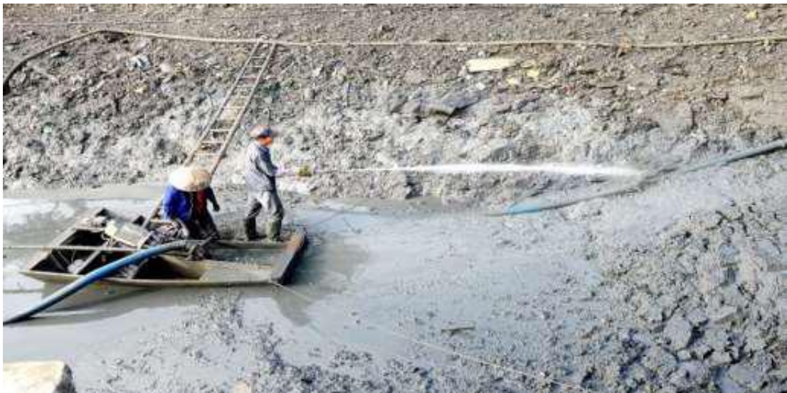
图 6.4.2 打坝抽水施工
